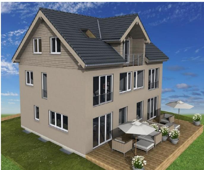
**Seefelderhofberg 6:** Neubau eines Dreifamilienhauses (Fotomontage) an Stelle von Garagen, die abgerissen werden. Grundfläche 10,0 x 14,0 m, Wandhöhe 5,78 m, Firsthöhe 10,02 m, Dachneigung 35°, Nachweis von 10 Stellplätzen (incl. Bestandsbau). Da sich das Gebäude in die Umgebung einfügt (eine Liste von Vergleichsbauten wurde von der Gemeindeverwaltung erstellt), erteilte der Gemeinderat sein Einvernehmen (einstimmig).
